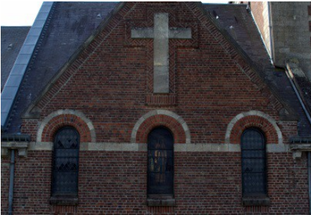
1 la croix en ciment et briques en chevron, extérieur côté cimetière.
