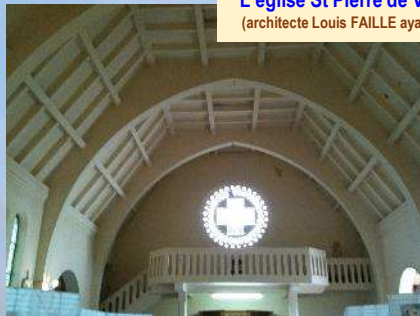
La « rose » en cives (pièces de verre circulaires éclairant le fond de l'église au-dessus de la tribune en béton)
