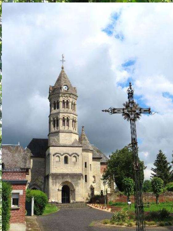
L'église St Pierre et son clocher-porche octogonal reconstruit à l'identique en 1922 architecte : C. Cocquempot
