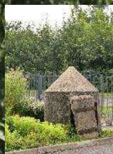
Blockhaus construit par les allemands surveillant l'aiguillage.
