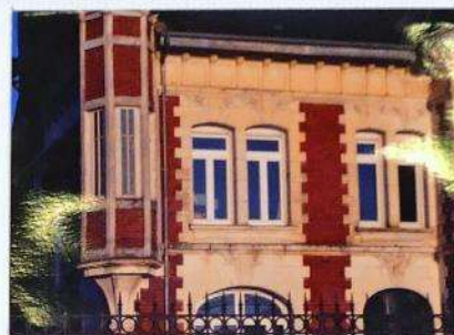
Structure en forme de tour à l'angle de la maison
