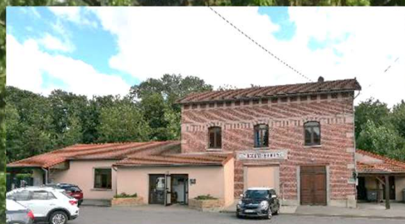
L'ancienne gare (au bord de la voie St Just – Douai) transformée en salle des fêtes.
